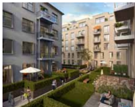
„May & Nielsen“ in Berlin-Weißensee, saniertes historisches Gebäude mit modernen Neubauten
